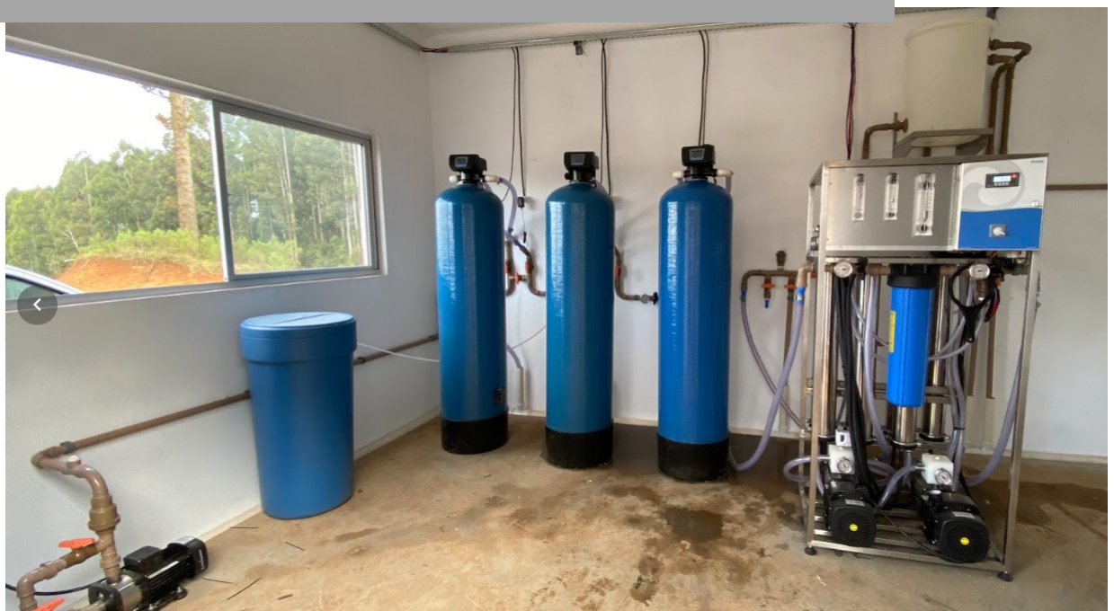
OSMOSE REVERSA LINHA ECO EM DUPLO PASSO INSTALADA EM SANTA CATARINA COM SISTEMA COMPLETO DE PRÉ-TRATAMENTO
